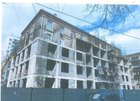
Рис. 9. Частично возведенные конструкции надстройки.
