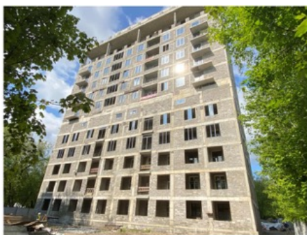
Рис. 10. Полностью возведенные конструкции надстройки.
