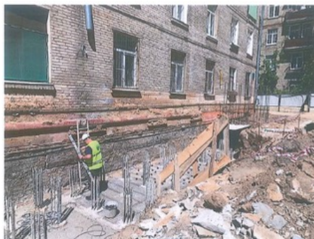
Рис. 8. Устройство монолитного ростверка под опоры надстройки.
