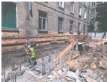
Рис. 8. Устройство монолитного ростверка под опоры надстройки.
