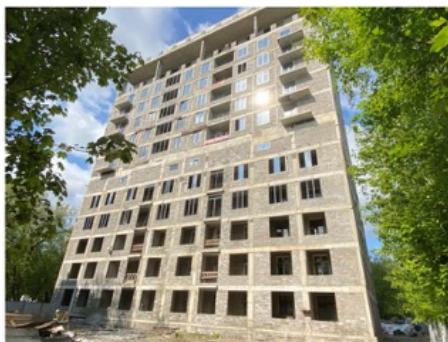
Рис. 10. Полностью возведенные конструкции надстройки.
