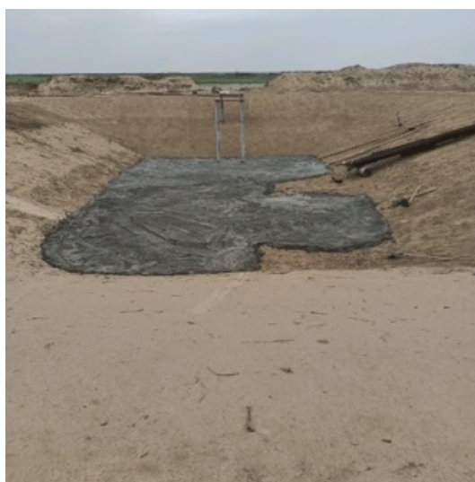
Рис. 6. Бетонирование дна водоёма
