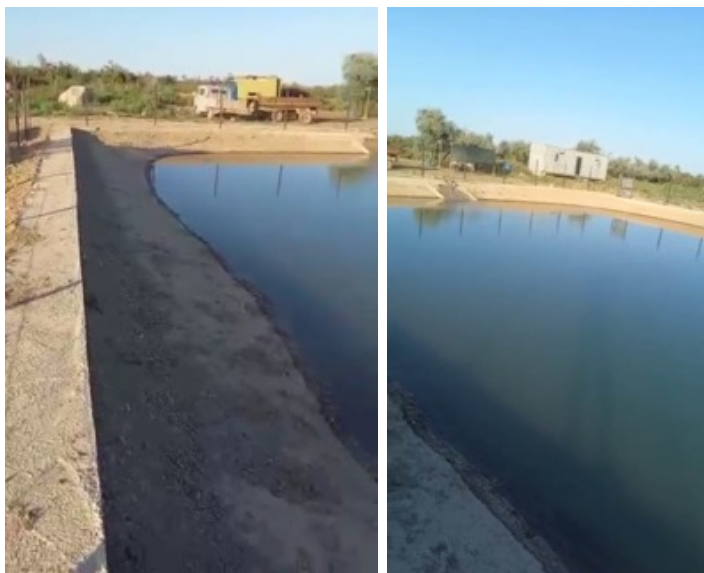
Рис. 7. Водоем в Отырарском районе Туркестанской области Республики Казахстан в процессе заполнения. Видна конфигурация береговых откосов, береговая бетонная отмостка, съезд в водоем, ограда водоема.
