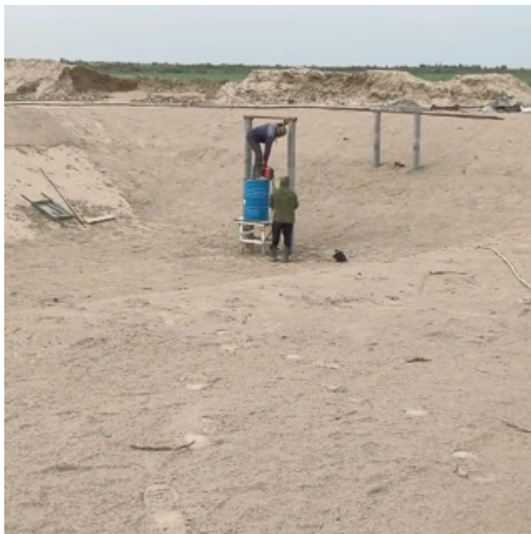
Рис. 4. Котлован водоема. Для возможности очистки дна водоема от постороннего мусора был предусмотрен мостовой заход со спусковыми лестницами, опоры которого видны на фото
