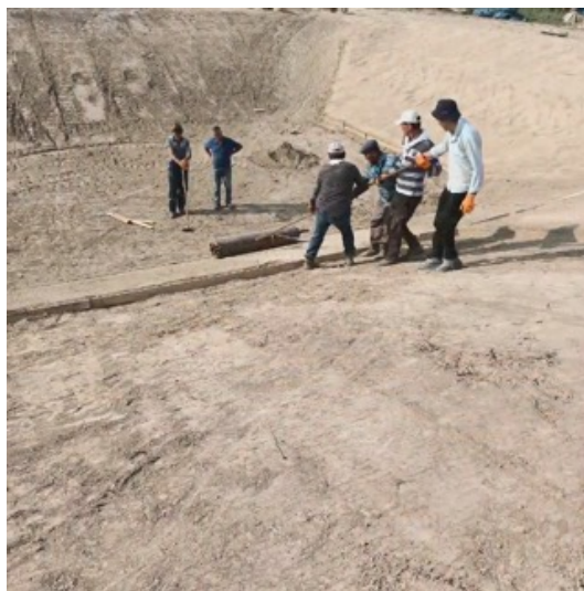
Рис. 5. Укатка ручным катком боковых откосов котлована
